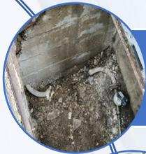
Remplacement de canalisation plomb d'eau potable en zone urbaine par un tuyau de poly-éthylène
